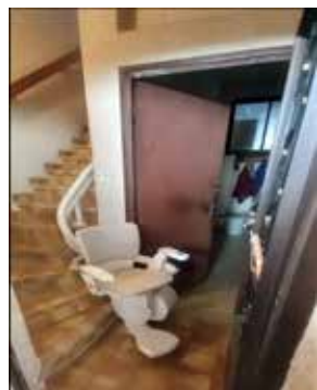
Visite fin de travaux à Vallouise-Pelvoux Installation d'un monte-toilette
