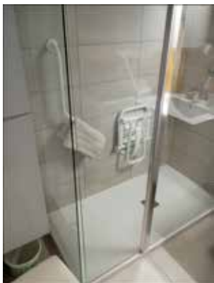
Visite fin de travaux à Embrun Salle de bain adaptée
