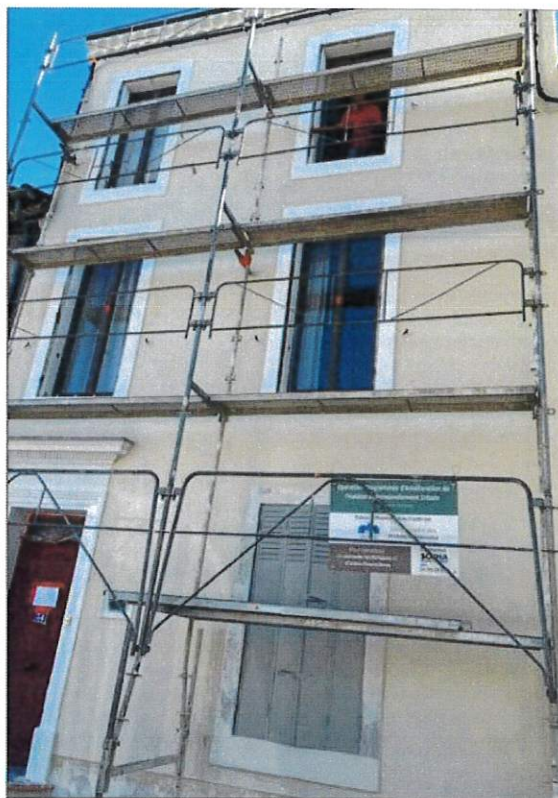
Une façade rénoverée sur le cours Tivoli (prime patrimoine) qui contribue à l'embellissement de la ville.
