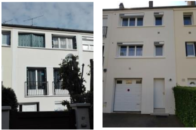
Isolation par l'extérieur (ITE) Avant et après travaux
